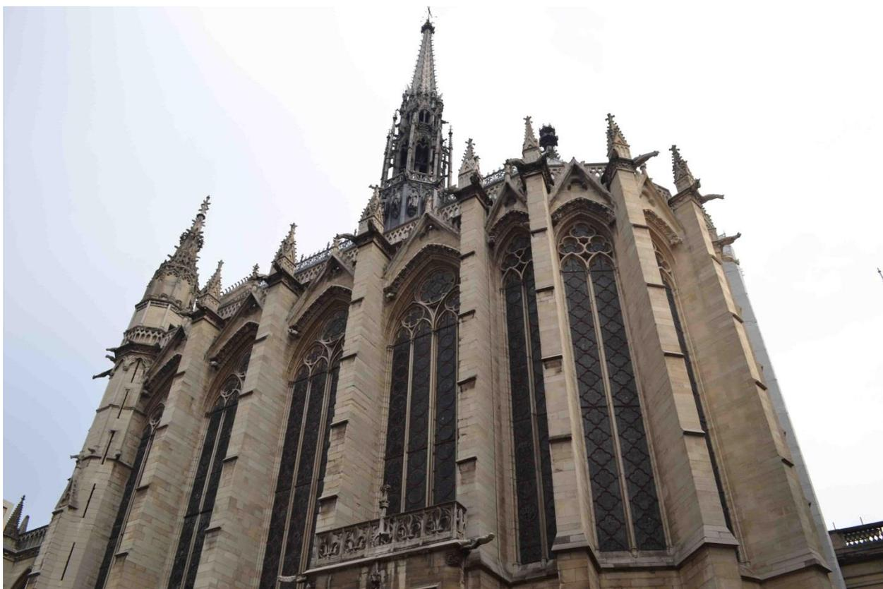
Маленькие размеры позволили обойтись без контрфорсов и аркбутанов, но снаружи видна толщина ребер, на которые опираются своды – в романском храме такую же толщину имела бы сплошная стена. Здесь же вместо стен – огромные окна, верхняя часть которых заполнена ажурной резьбой (masswerk):
